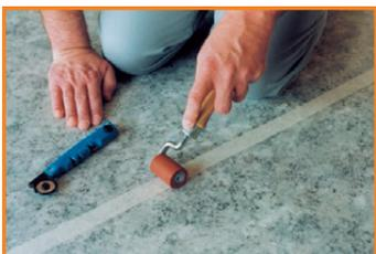
Presione con fuerza la cinta adhesiva de papel con un rodillo de presión (Art. Nr. 50020) sobre el revestimiento de suelo de PVC.
