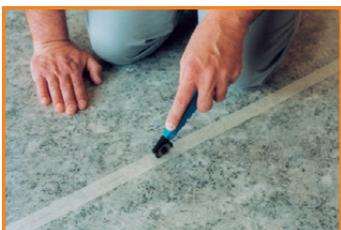
Corte la cinta adhesiva en la zona de la costura con una cuchilla rodante (n.º del art. 50010) de forma sencilla y segura (otra opción: utilizar una cuchilla trapezoidal).
